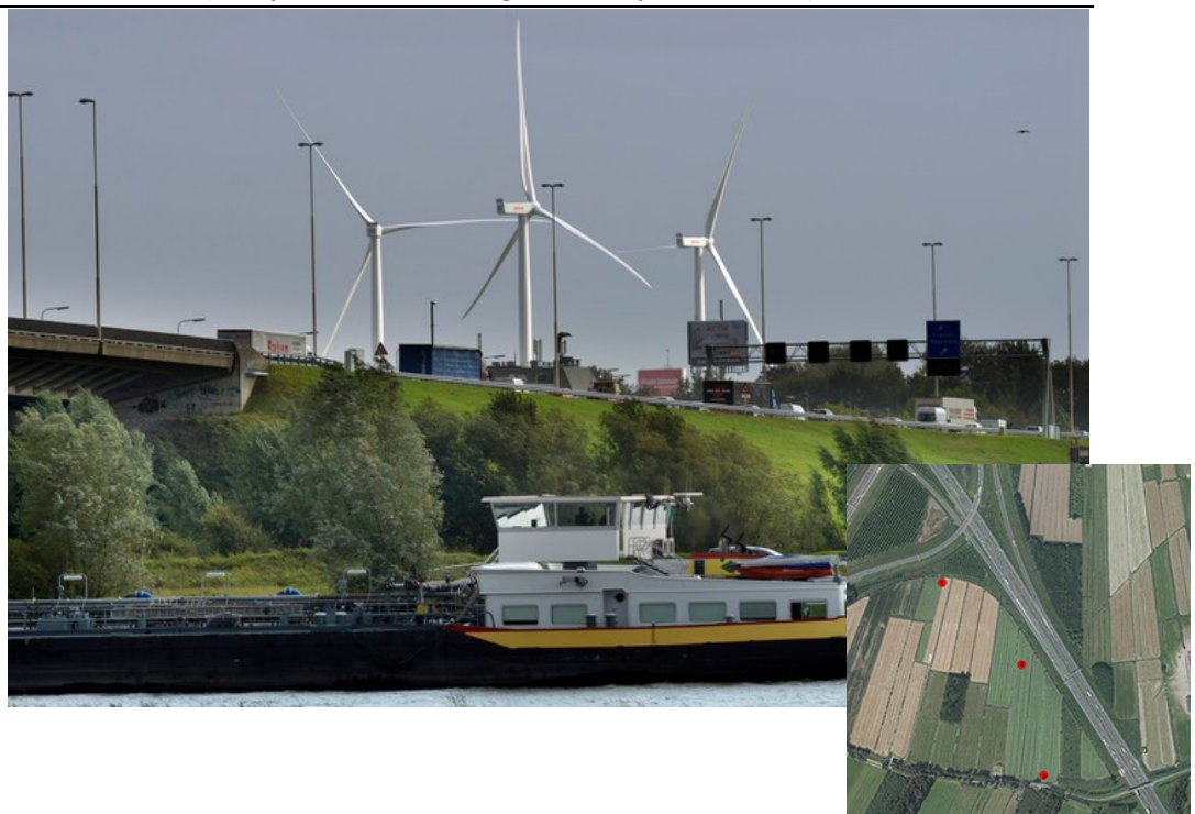
Figuur 37 Voorbeeld van een lijnopstelling met een lichte kink die vanuit bepaalde hoeken niet als zodanig waarneembaar is (Windpark Autena Vianen, gemeente Vijfheerenlanden).
